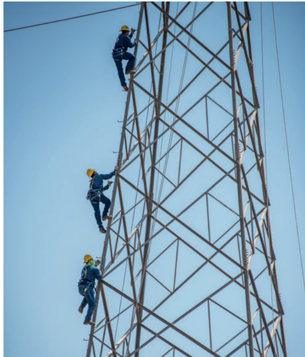
Fotografía 36. Trabajos en torre de transmisión. Puerto Vallarta, Jalisco. CFE.
